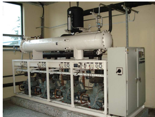
Slika 6: Hladilni agregat
