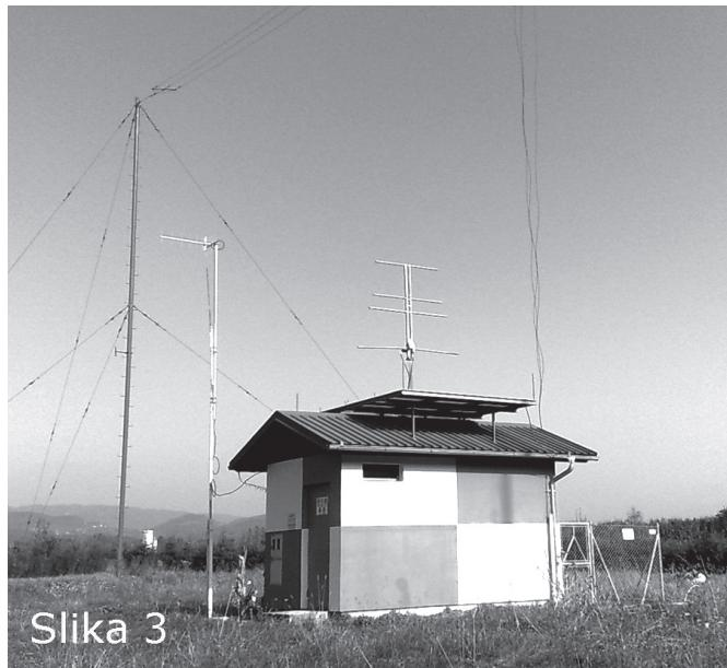
**Slika 3 - V Sloveniji je sedem »aero NDB« oddajnikov za potrebe avio navigacije med letališči. Na sliki je antenska hišica LF NDB oddajnika »MG« pri Mengšu, ki svoj nosilni signal oddaja na frekvenci 296 kHz, ID pa LSB/USB 1020 Hz, v presledku 7 sekund. Tu je aktiven tudi oddajnik »outer markerja« na 75 MHz, ki letalu v pristajanju javlja mesto, ki je eno miljo oddaljeno od začetka pristajalne steze brniškega letališča.**
