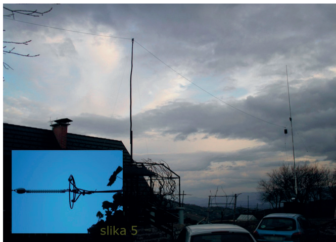
Slika 5: položaj antene v prostoru. Okoli 6 do 7 metrov iznad zemlje oziroma kovinske konstrukcije brajde. Aluminijska antenska pletenica premera 6mm, je zaključena z malim kapacitivnim zaključkom premera 20 cm iz istega materiala kot antena.
