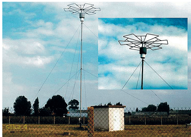
Slika 4: primer profesionalne izvedbe »top-hat« tuljave na aero NDB Merville-Francija; 404 kHz. Antena je po modifikaciji pol krajša in večjim dometom signala kot pri stari izvedbi. Okvirni premer tuljave je cca 1m s Q cca 1000.
