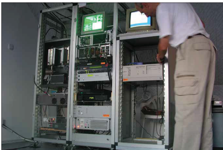
Slika 17 - Montaža WLAN opreme na repetitorski postojanki
