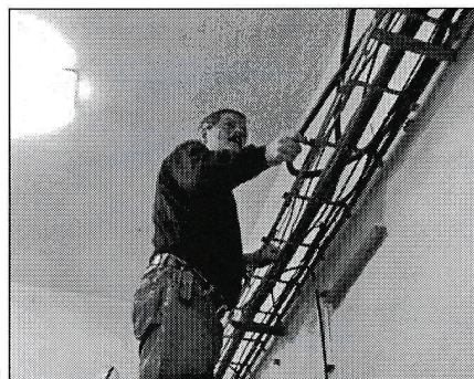
Slika 12 - Nameščanje antenskega kabla (S51UL)
