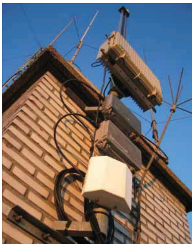
ONOMTV DATV repetitor, nameščen na drogu
