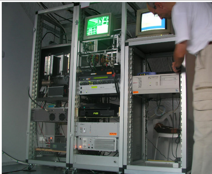
Slika 2.4 - Montaža WLAN opreme na oddajni postojanki
