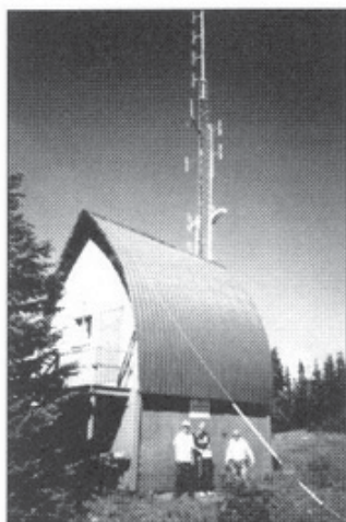
Zemeljska postojanka z repetitorjem omrežja IPARN.
