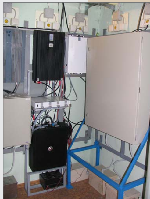
Slika 5 - 2m, 70cm in 6m repetitor, krmilnik in sito
