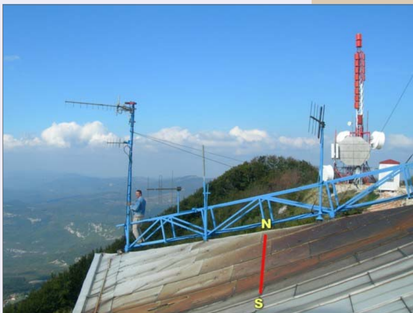
Sliki 18 in 19 - Še pogled na oddajni center iz višine
