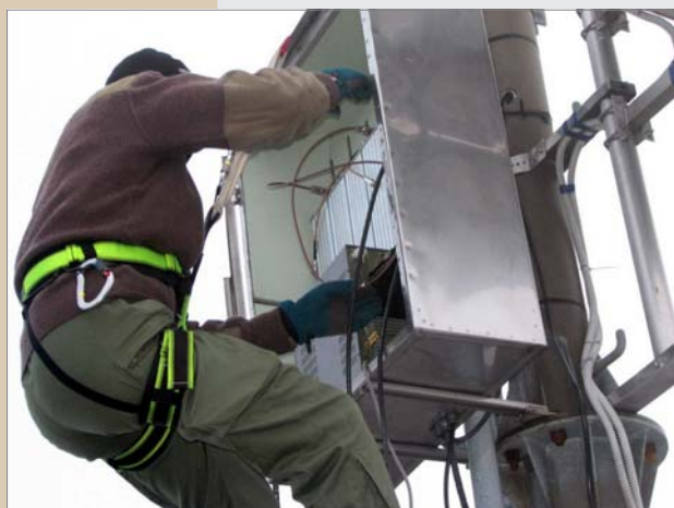
Slika 5 - Demontaža UHF antene
