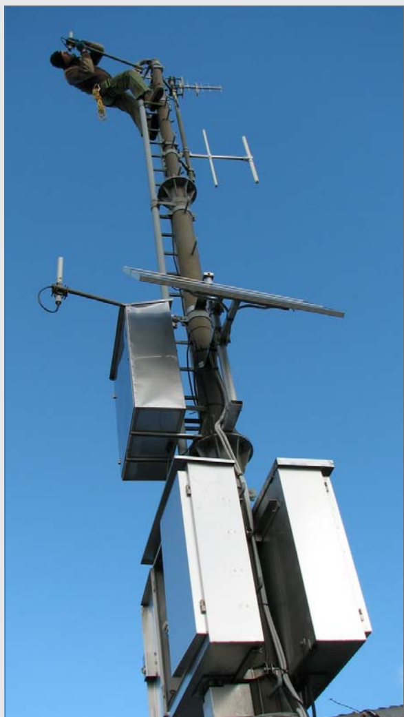
Slika 3 - Demontaža UHF antene
