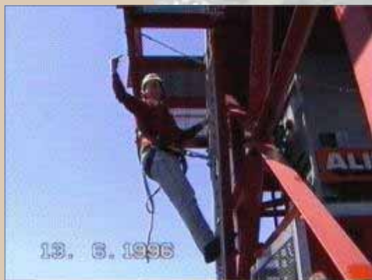
Slika / Bild 4 - Dieter, DF3VN beim Kabel verlegen bei Inbetriebnahme
