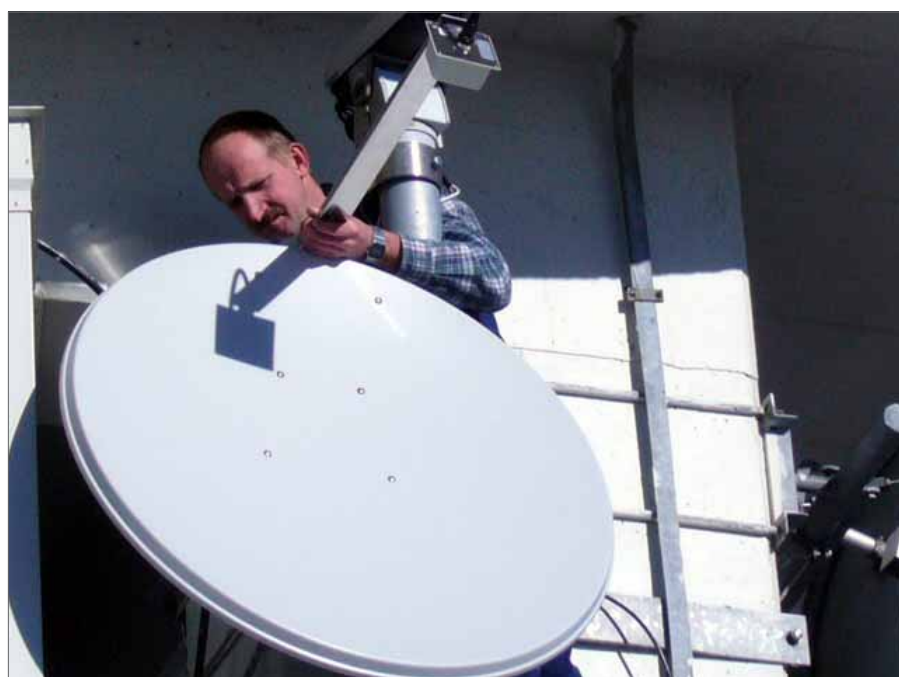
Slika 4 - montaža offset antene na višinski lokaciji
