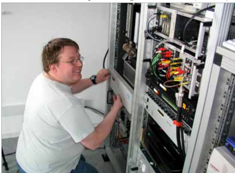
Slika / Bild 10 - Hendrik pomaga pri servisu na naši RPT postojanki / Hendrik hilft bei Wartung von S55TVA relais (Slowenien)
