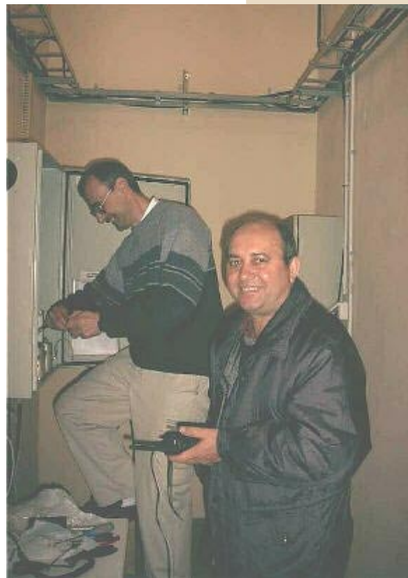
Vzdrževalna dela na S55URS repetitorju
